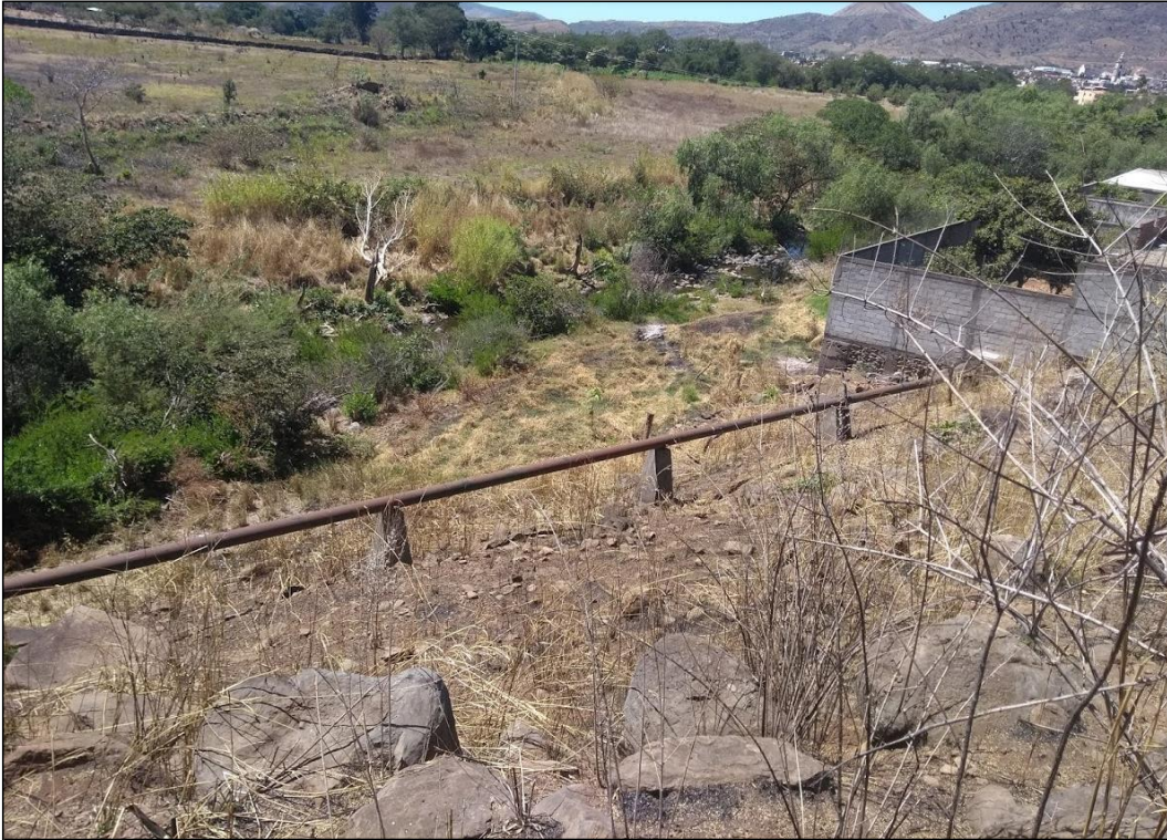
Vista al Sur del proyecto hacia el Río Grande y la tubería de drenaje sanitario.
